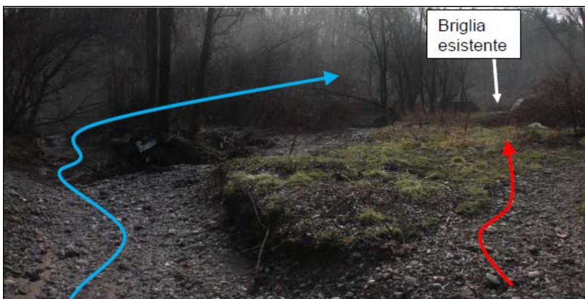
Figura 36: situazione inerente la briglia aggirata-vista da monte verso valle. Freccia Rossa=antico corso del rio; freccia Blu=corso del Rio attuale, accompagnato da una maggiore erosione dell'alveo.
