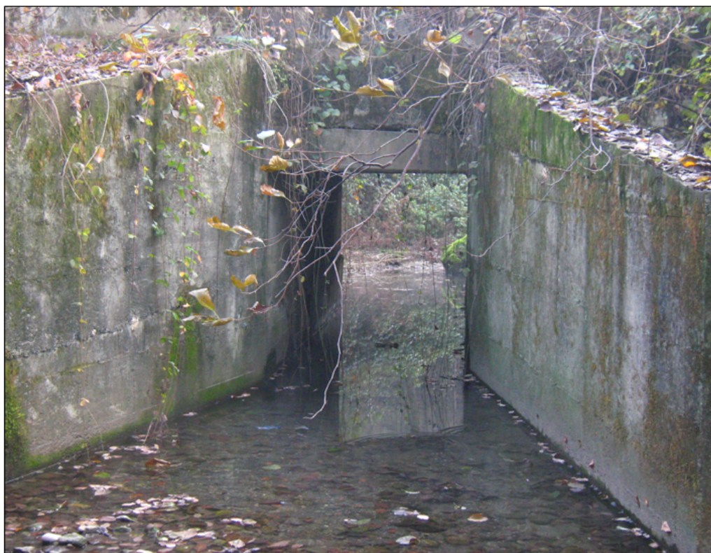
Figura 21 - Scatolare in calcestruzzo in corrispondenza dell'attraversamento di via della Valle
